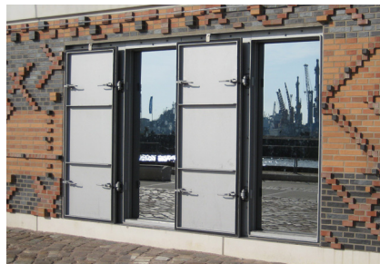
Waterdichte deuren Hamburg Hafencity (foto: Defacto)
