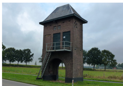
Transformatorkast Persingen (foto: Havang(nl) via wikimedia commons)
