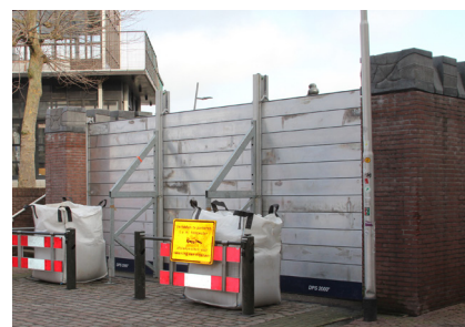
Afsluitbare kering Nijmegen (foto: Defacto)
