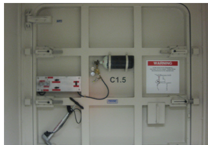
Waterdichte deuren in het Texas Medical Centre (foto: Defacto)
